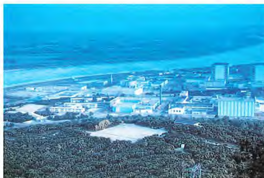
Site de Marcoule – Vue aérienne d'Atalante
