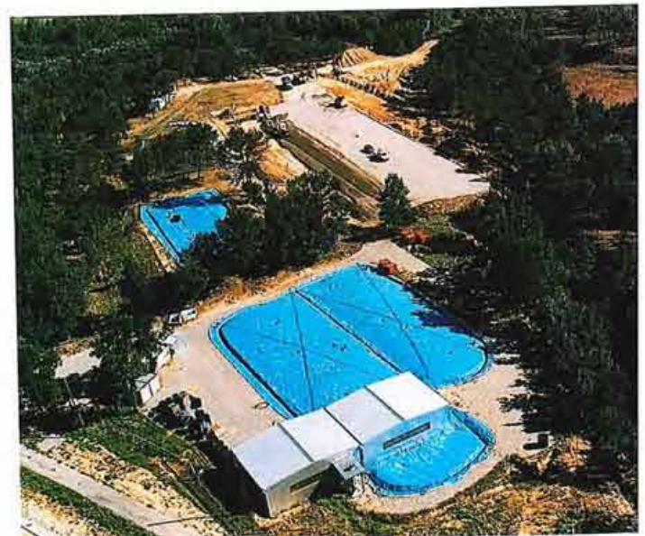
1999 : reprise des fûts enfouis dans les tranchées
