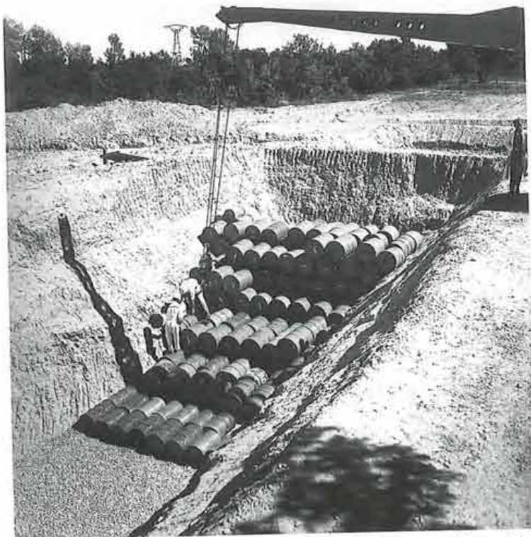
1968-1970 : enfouissement de fûts de déchets dans des tranchées du parc d'entreposage du site CEA de Cadarache
