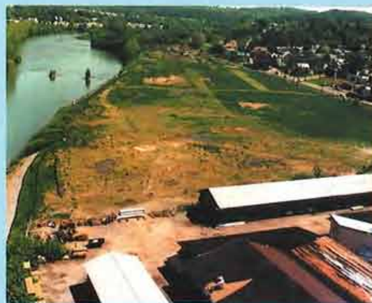
A la fin des travaux de déclassement
