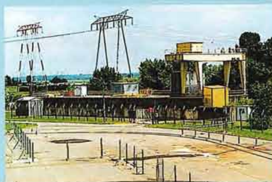
Site EDF de Saint-Laurent-des-Eaux : silos d'entreposage de déchets de graphite
