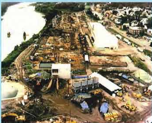
En cours d'assainissement
