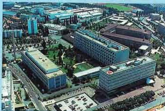
Site CEA de Fontenay-aux-Roses
