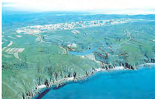
L'établissement COGEMA, l'anse des Moulins et la conduite de rejet
