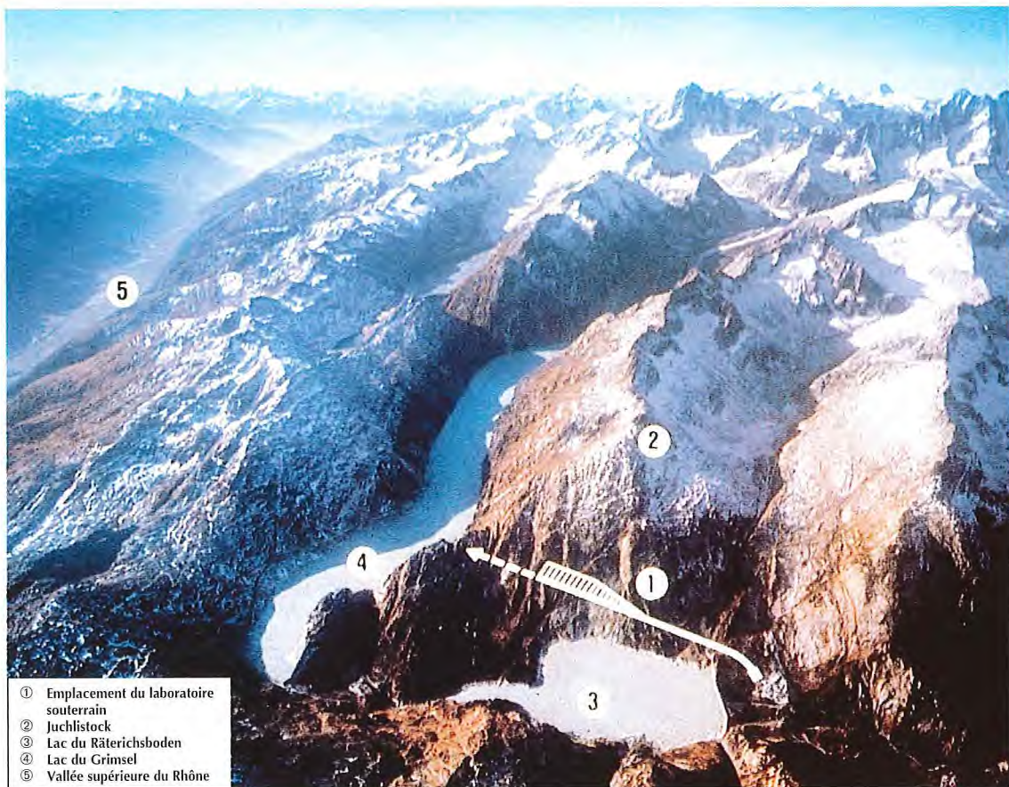
Vue générale de la région du Grimsel. Le laboratoire souterrain du Grimsel est situé sous le versant est du Juchlistock qui s'élève entre les lacs artificiels du Räterichsboden et du Grimsel
