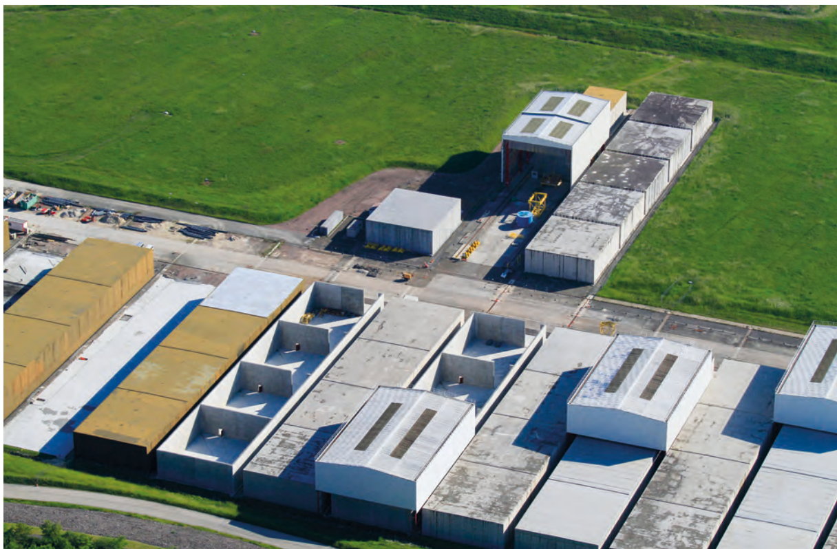
Centre de stockage FMA de l'Aube.
