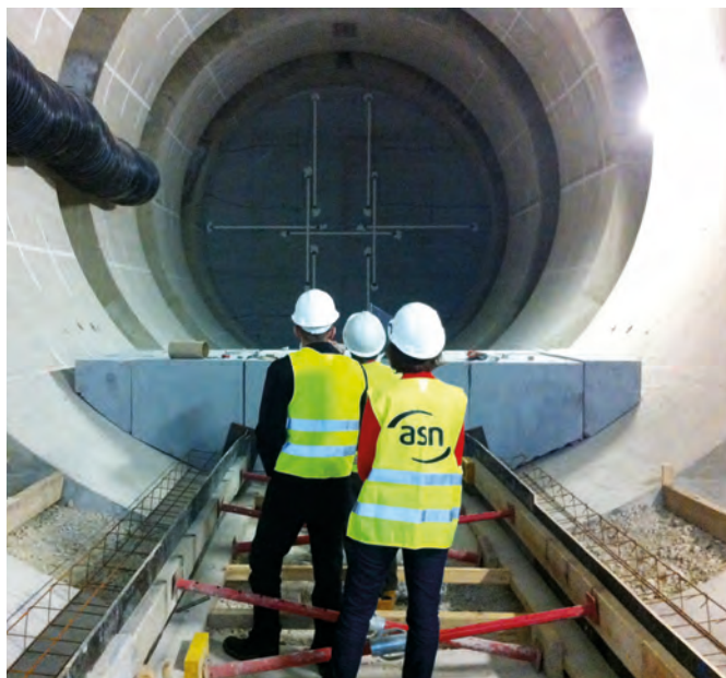
Inspection de l'ASN sur le site d'essai de scellement en surface à Saint-Dizier, avril 2014.
