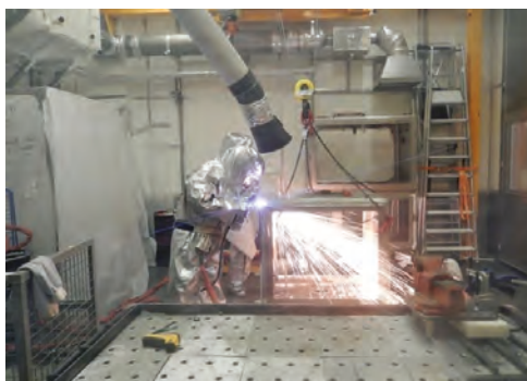
Chantier de démantèlement de l'ATPu.
