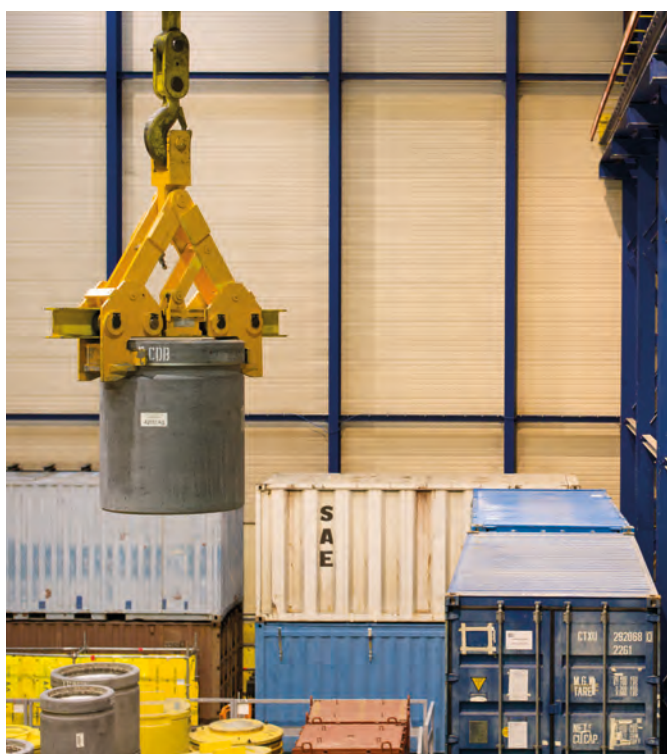
Manutention de coques béton dans le bâtiment de traitement des effluents, à la centrale nucléaire de Saint-Alban/Saint-Maurice, novembre 2013.
