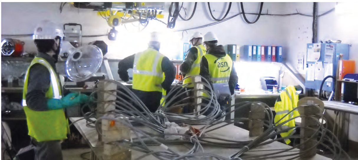
Inspection de l'ASN sur le chantier EPR de Flamanville : préparation des câbles électriques avant tirage, février 2014.
