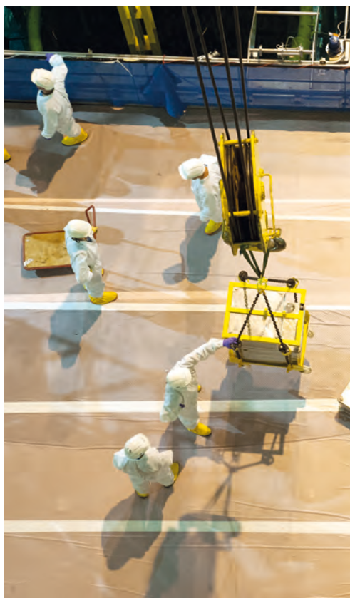
Centrale nucléaire de Civaux, le bâtiment réacteur pendant l'arrêt de tranche, août 2014.
