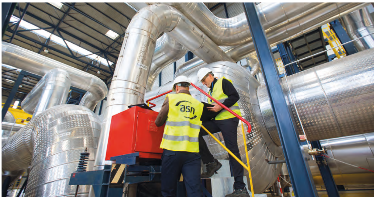
Inspecteurs de la division de Lyon de l'ASN à la centrale du Bugey, novembre 2014.
