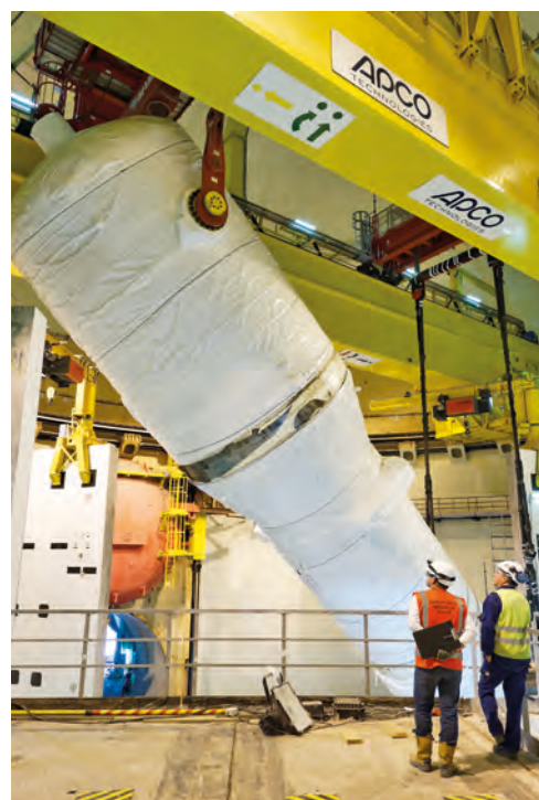
Installation sur le chantier EPR Flamanville du premier générateur de vapeur, septembre 2014.
