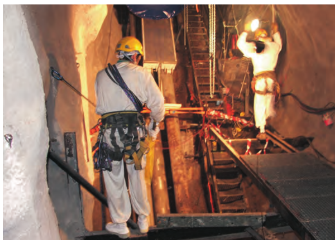
Chooz A – démantèlement du carneau de ventilation
