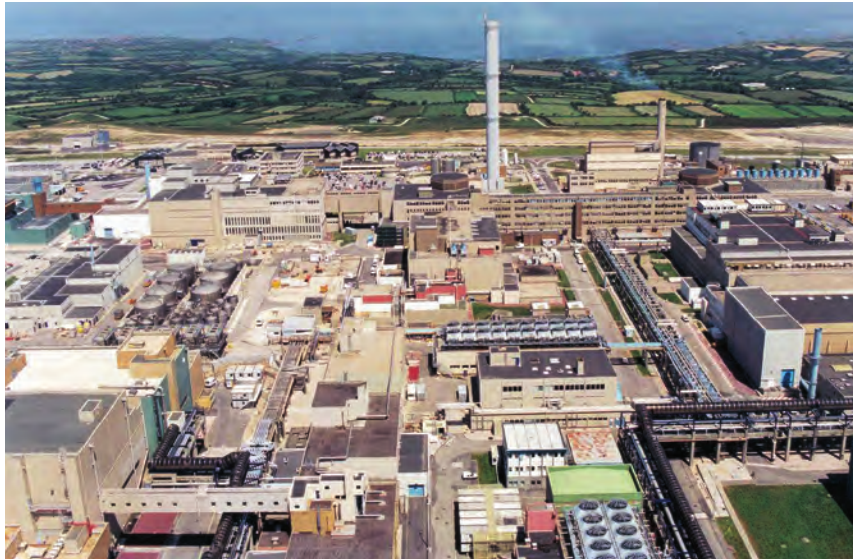
COGEMA La Hague – vue générale
