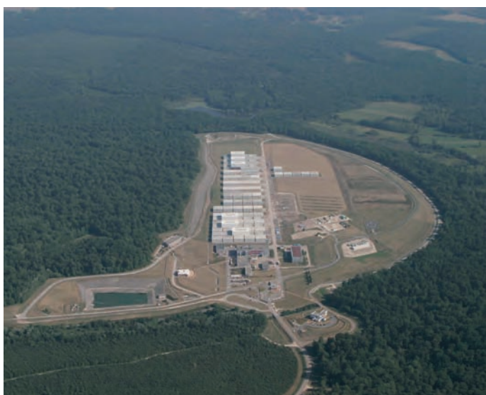
ANDRA – Centre de stockage de l'Aube
