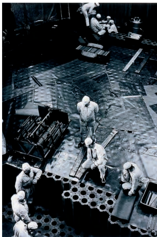
Assemblage de graphite dans un réacteur UNGG
