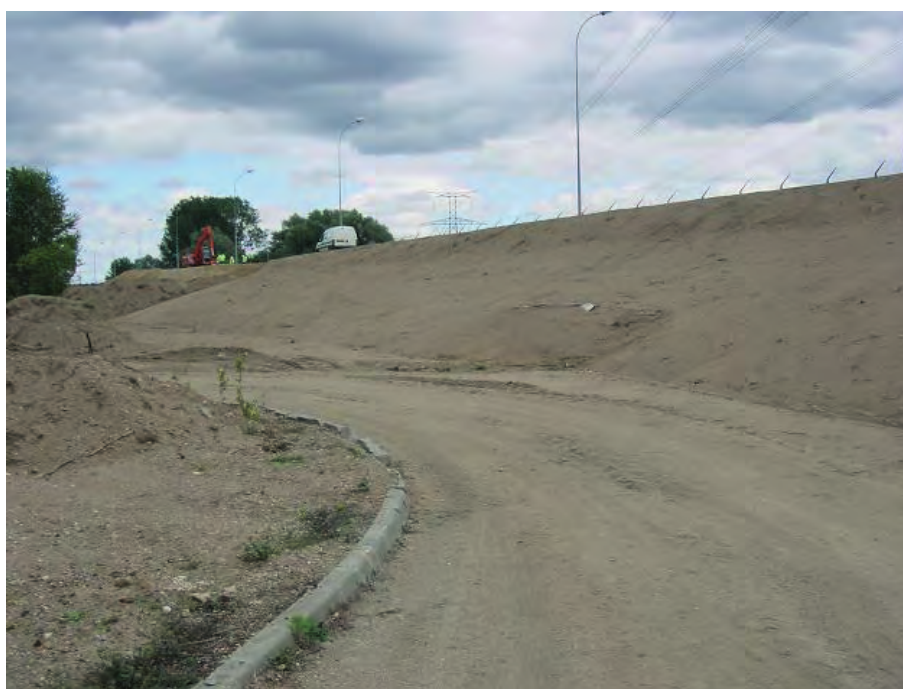
Digue périphérique de protection de la centrale de Belleville (Loire)
