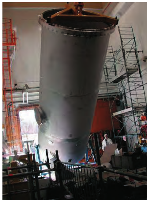
Arrivée du caisson boucle à eau dans le réacteur CABRI
