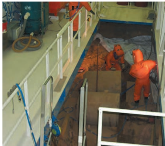
Chantier de reprise des tranchées de l'INB n° 56
