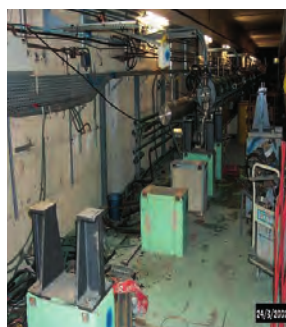
ALS avant le démantèlement
