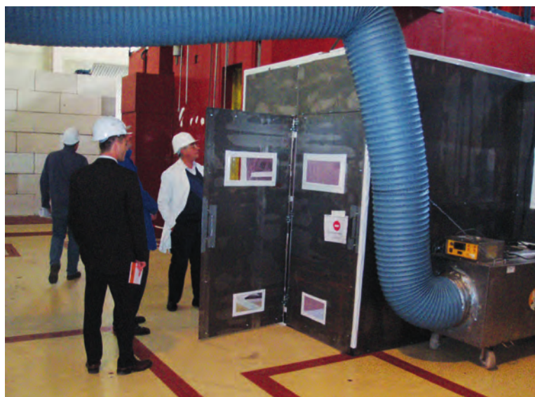
Inspection de l'ASN d'une casemate mise en place pour les travaux de démantèlement du RUS le 4 octobre 2006
