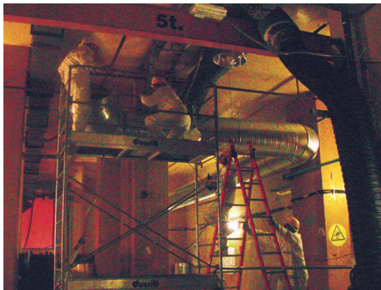
Centrale des Monts d'Arrée-Brennilis – rénovation de la ventilation
