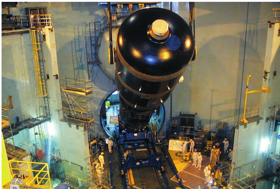
Remplacement d'un générateur de vapeur
