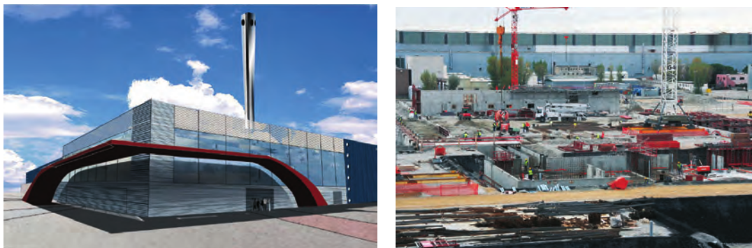
GBII – chantier de l'installation
