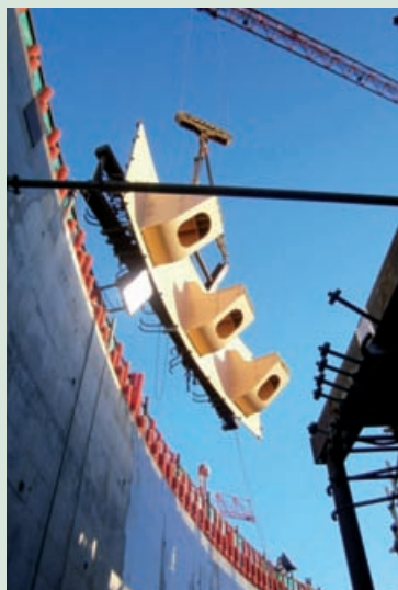
Mise en place de consoles sur l'enceinte interne du bâtiment réacteur de l'EPR de Flamanville 3
