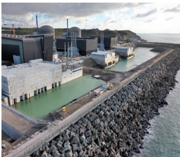
Vue aérienne du chenal d'amenée d'eau du site de Flamanville, lors de la mise en eau de la station de pompage de Flamanville 3 – Novembre 2012
