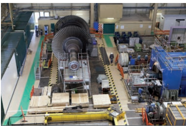
Travaux de maintenance pendant l'arrêt du réacteur 3 de la centrale nucléaire de Paluel – Juin 2012
