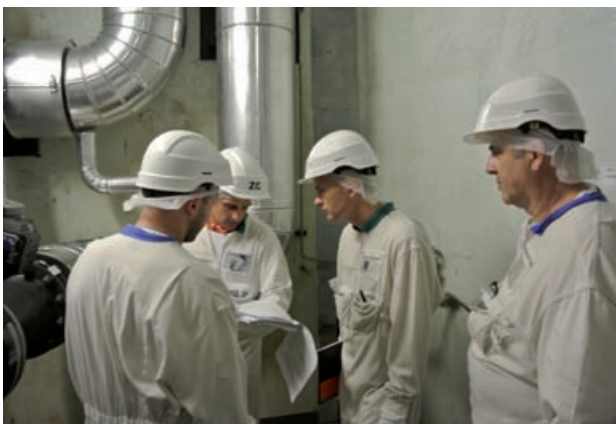
Inspection de l'ASN sur la conduite accidentelle à la centrale nucléaire du Blayais (en zone contrôlée) – Octobre 2012
