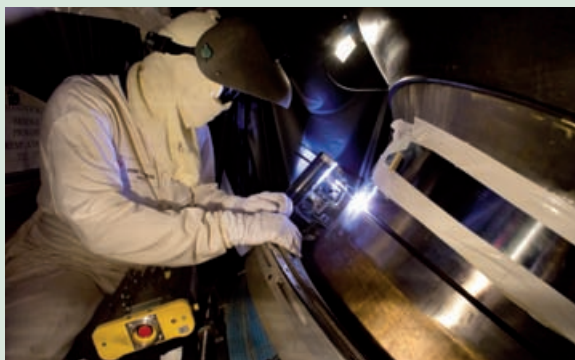
Opération de soudage Tig Orbital Chanfrein Etroit (TOCE) : raccordement du générateur de vapeur à la tuyauterie primaire côté branche chaude
