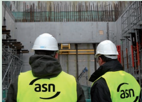
Inspection sur le thème du génie civil du bâtiment diesel nord – Décembre 2012
