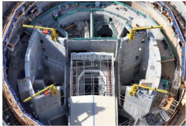
Vue aérienne du bâtiment réacteur de l'EPR de Flamanville – Septembre 2012
