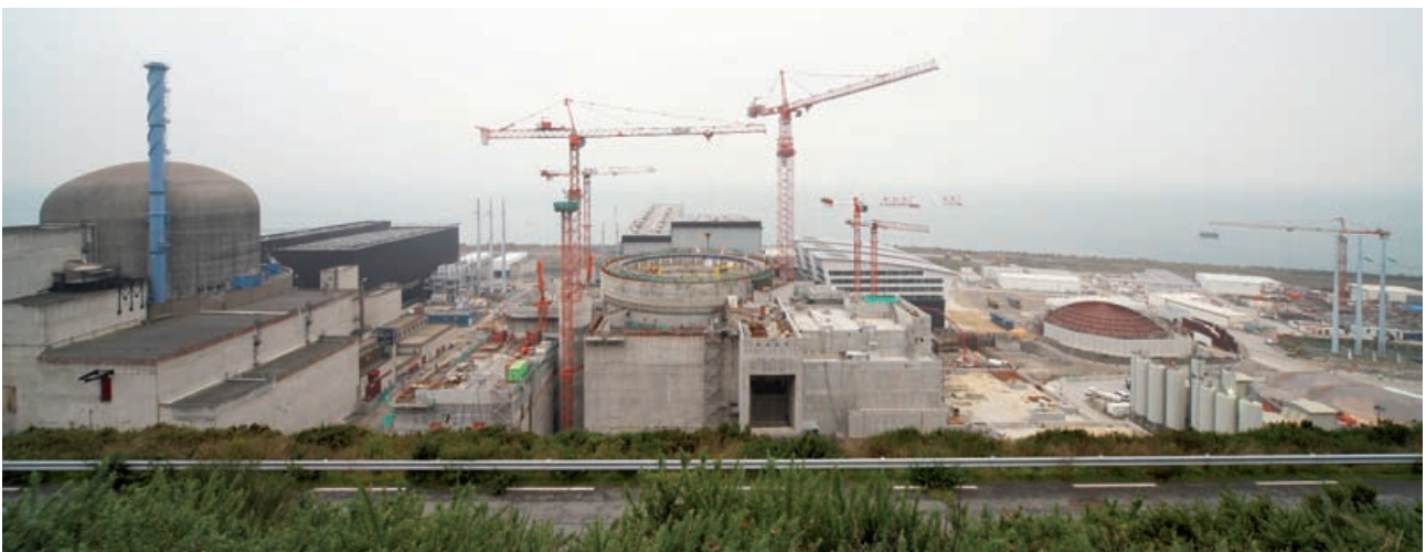
Vue d'ensemble du chantier de l'EPR à Flamanville – Octobre 2012
