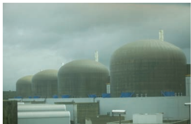
Bâtiments réacteurs de la centrale nucléaire de Paluel
