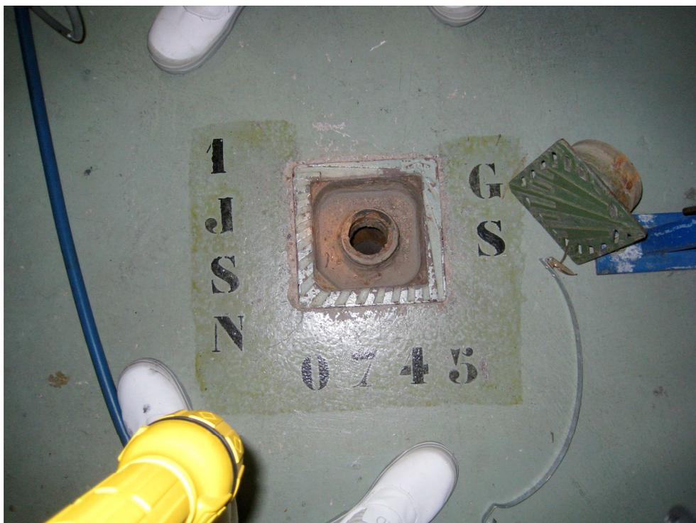
L'insuffisance dans l'application de la consigne de remplissage hebdomadaire des siphons de sol des locaux d'exploitation avait déjà été constatée lors de l'inspection précédente. Ce point a fait, à nouveau, l'objet d'un constat d'écart notable.
