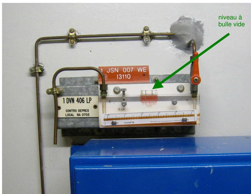
**A2. Je vous demande de contrôler les niveaux à bulles sur l'ensemble des micro-manomètres présents au droit des portes d'accès aux locaux à risque iode et de procéder à leur remise en conformité.**
