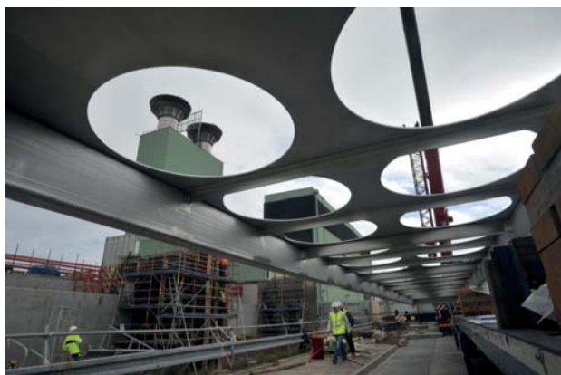
Chantier de l'extension d'entreposage des verres sur le site de La Hague (EEVLH)
