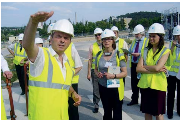
Visite du chantier du réacteur Jules Horowitz (Cadarache) par les membres de la Commission franco-allemande le 10 mars 2011
