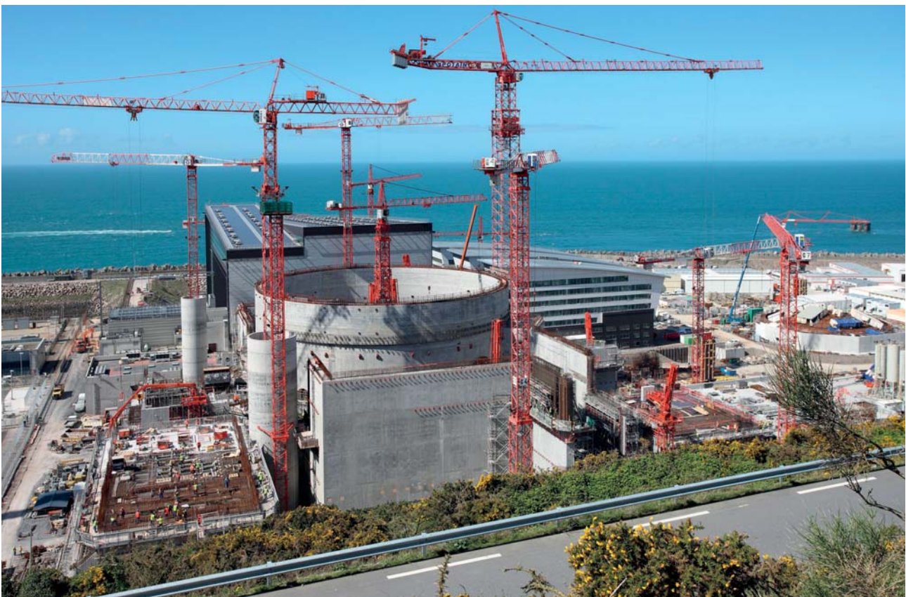
Vue générale du chantier EPR Flamanville 3 – Août 2011
