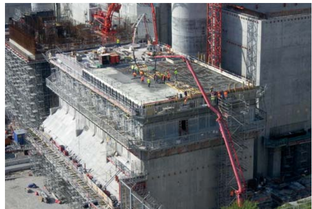
Vue du bâtiment diesel sud – Août 2011
