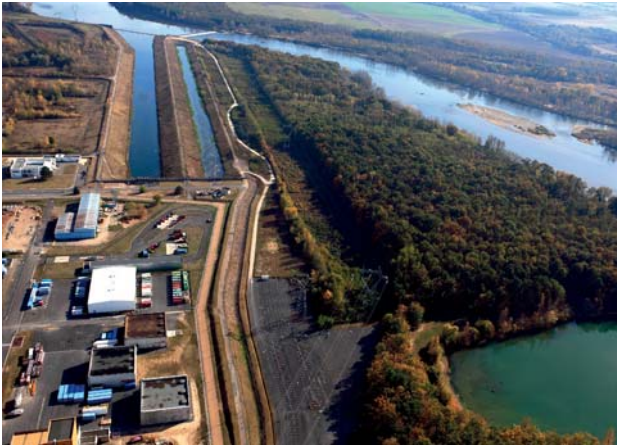
Ouvrages de prise d'eau et de rejets en Loire de la centrale nucléaire de Dampierre-en-Burly
