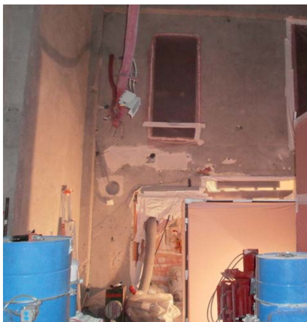
Travaux d'assainissement du « bâtiment U02 » avant déconstruction
