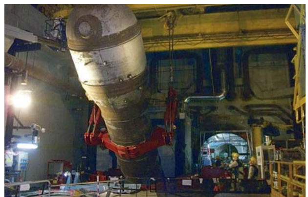
Dépose d'un générateur de vapeur du réacteur CHOOZ – Octobre 2011
