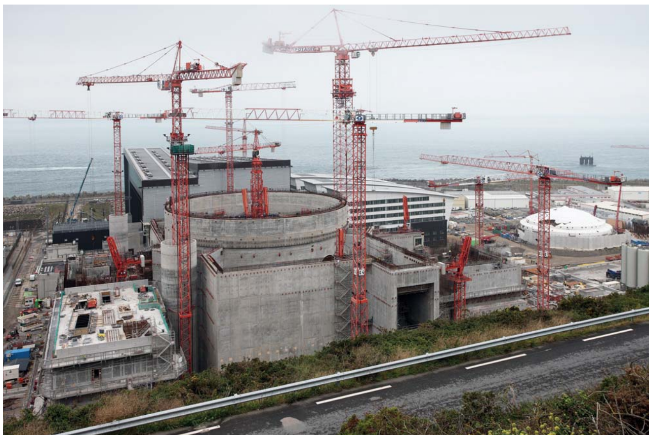
Vue générale du chantier du réacteur EPR de Flamanville – Septembre 2011
