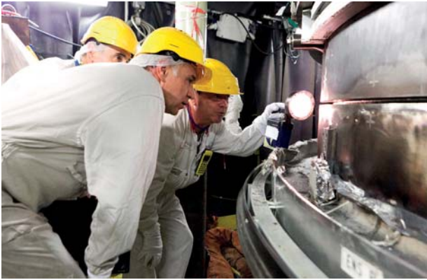
Contrôle de la soudure d'un joint sur un GV à l'occasion de la 3 e visite décennale de la centrale nucléaire de Fessenheim – Septembre 2011
