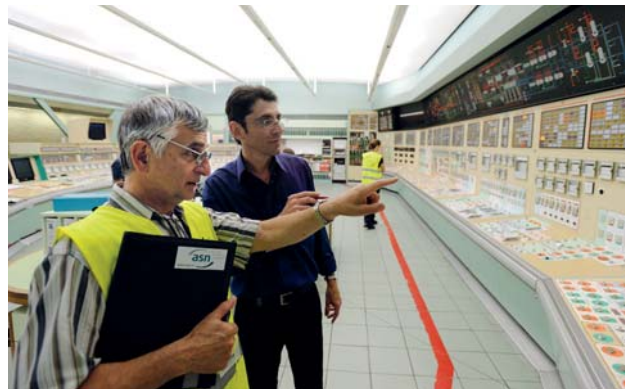
Inspection de l'ASN de la salle de commande lors de la visite décennale de la centrale nucléaire du Tricastin – Mai 2009
