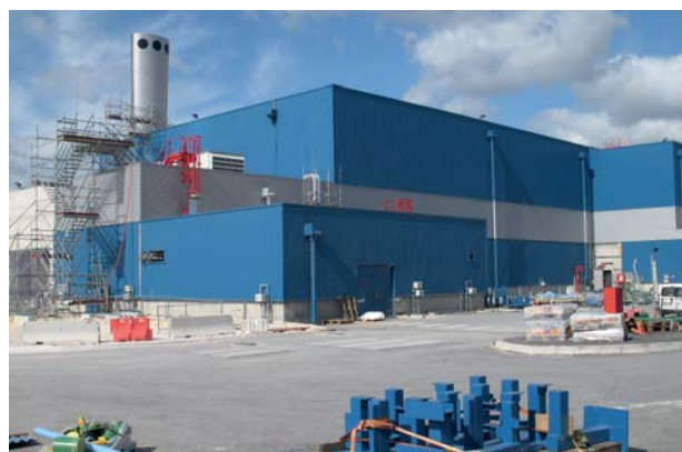
Vue extérieure de l'atelier en construction REC II de l'usine GEORGES BESSE II – Octobre 2011
