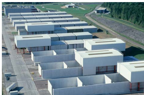
Vue aérienne des alvéoles de stockage de déchets FMA-VC (faible et moyenne activité à vie courte) du centre de stockage FMA de l'Aube
