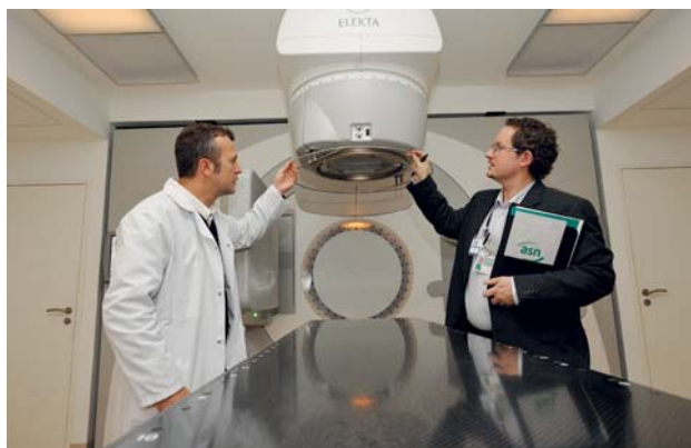
Inspection de mise en service d'une installation de radiothérapie à la clinique des Dentellières à Valenciennes – Octobre 2011
