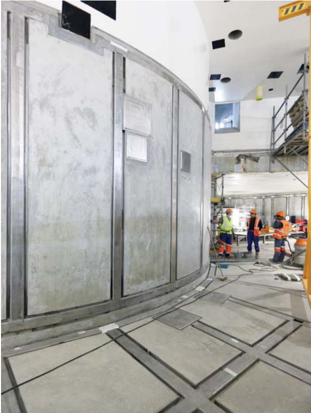
Vue de la piscine IRWST du système RIS de Flamanville 3 avant entôlage – Septembre 2011
