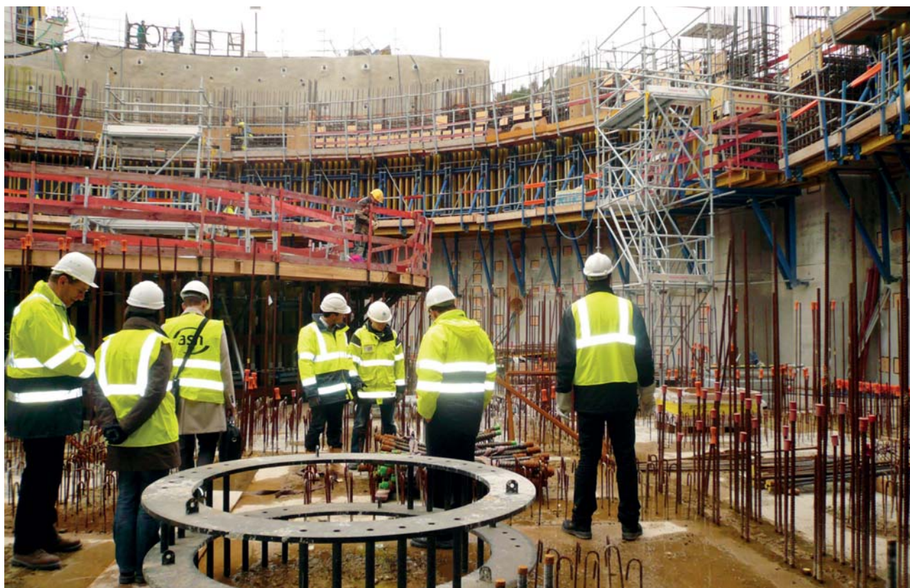
Inspection de l'ASN sur le chantier du réacteur Jules Horowitz – Décembre 2011
