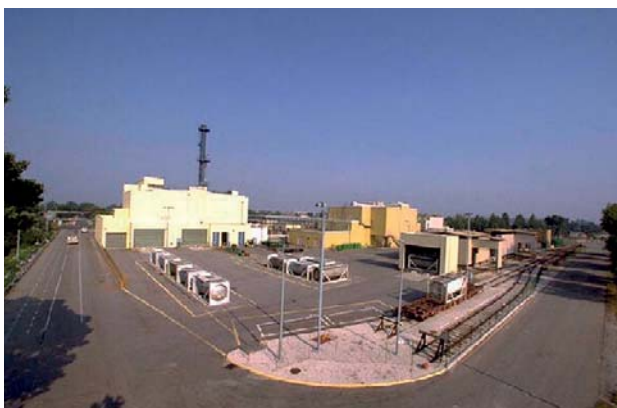
L'installation TU5 sur le site du Tricastin
