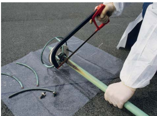
Découpe de la tête d'un paratonnerre
