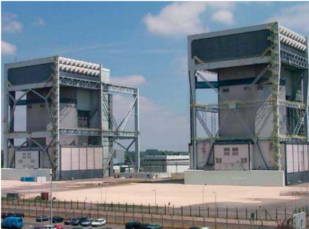
Vues de la centrale nucléaire de Saint-Laurent-des-Eaux avant et après travaux
