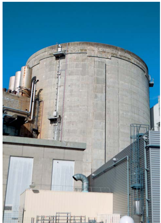
Enceinte de confinement d'un bâtiment réacteur sur la centrale nucléaire de Fessenheim
