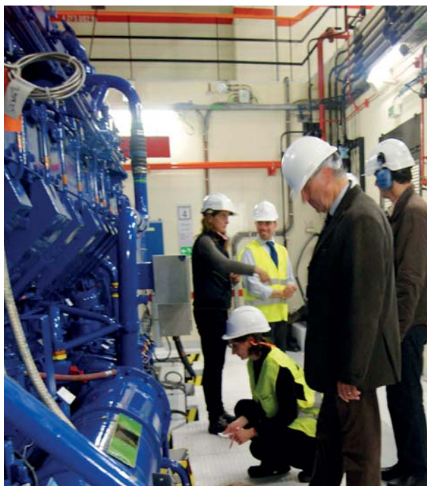
Inspection post-Fukushima de l'ASN à la centrale nucléaire de Cruas – Octobre 2011
