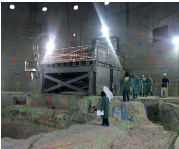
Inspection de déclassement de l'ASN du radier du réacteur SILOÉ – Décembre 2011
