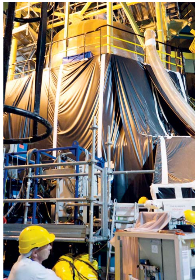
Surveillance du chantier de remplacement des générateurs de vapeurs à l'occasion de la 3 e visite décennale de la centrale nucléaire de Fessenheim – Septembre 2011
