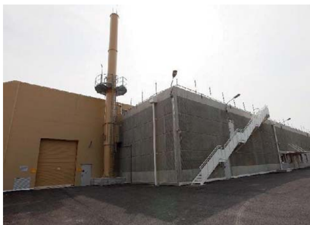
Vue de l'installation MAGENTA à Cadarache
