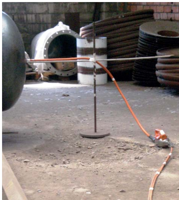
Appareil de gammagraphie sur chantier
