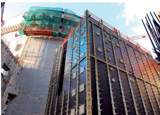
Panneaux de coffrage de la piscine de désactivation du bâtiment combustible de l'EPR – Novembre 2010
