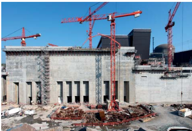
Début des travaux de toiture finalisant les activités de génie civil de la station de pompage – Avril 2011
