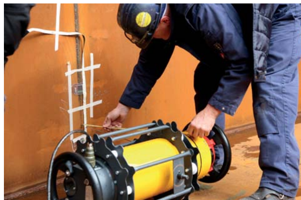
Mise en œuvre d'un générateur de rayons X en chantier
