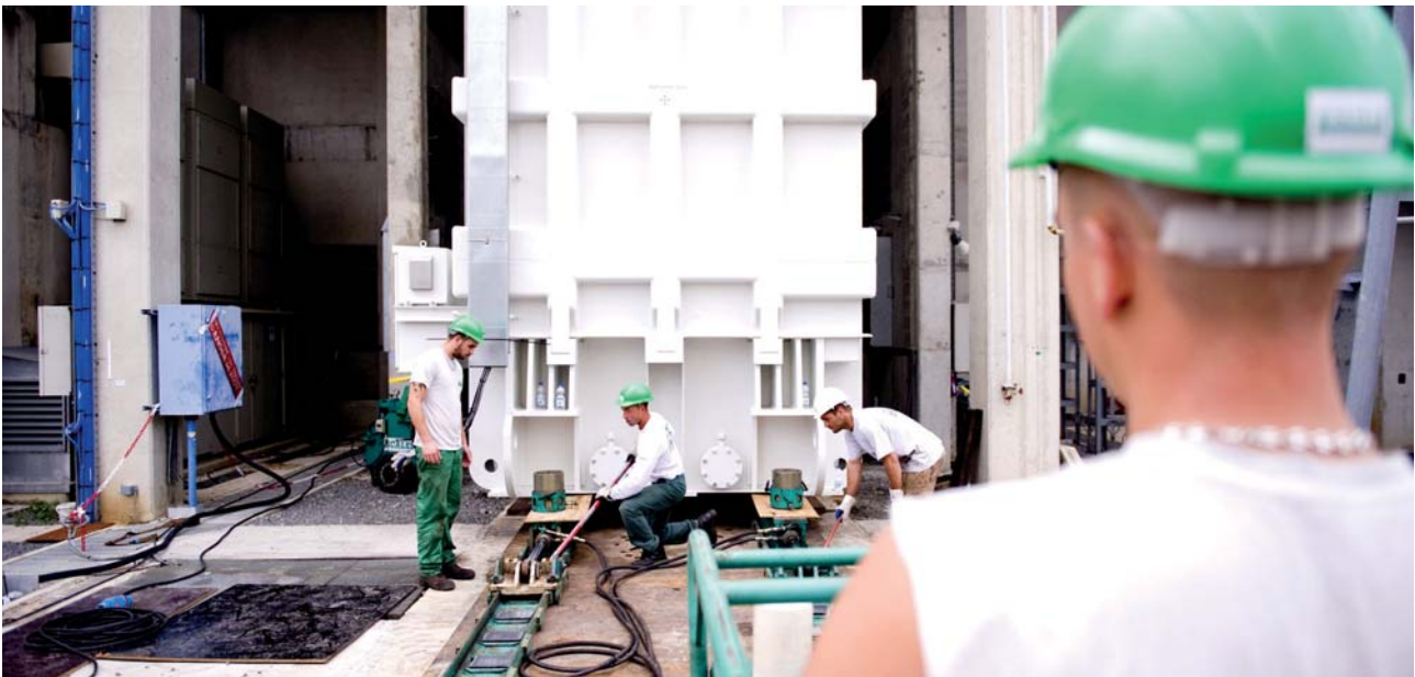
Prestataires sur le chantier de remplacement du transformateur N4 à la centrale nucléaire de Civaux – Juillet 2009
