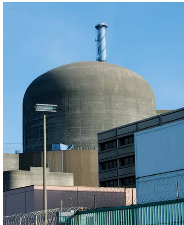
Vue de la coque béton d'un bâtiment réacteur de la centrale nucléaire de Flamanville
