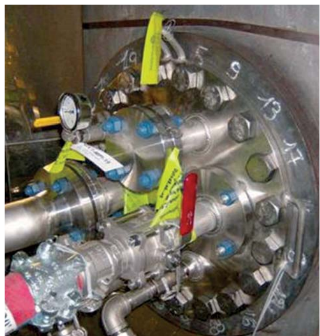
Installation des équipements lors du nettoyage chimique des générateurs de vapeur
