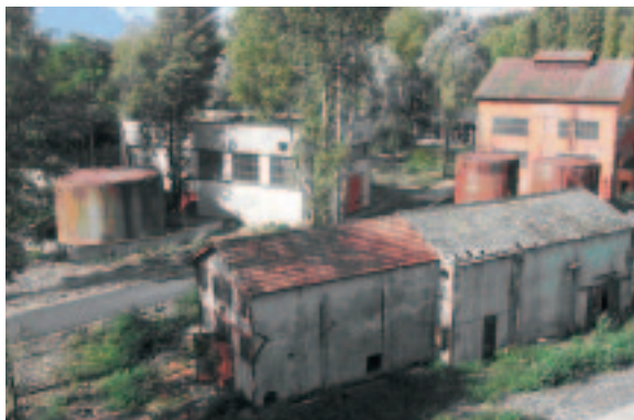
Site de l'ancienne usine CEA du Bouchet (Essonne) : vue aérienne d'anciens bâtiments avant la phase de démolition (juin 2001).
