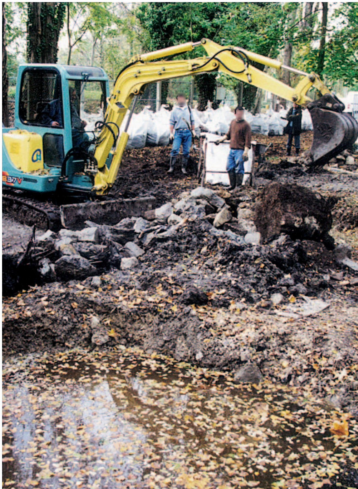
Réhabilitation du terrain CEA de l'Île Verte (Essonne). Vue pendant les travaux.
