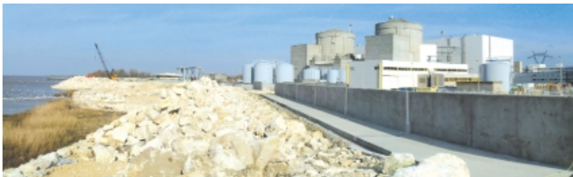
Sommet de la digue avec le mur anti-houle en construction
