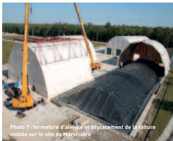
Photo 7 : fermeture d'alvéole et déplacement de la toiture mobile sur le site de Morvilliers
