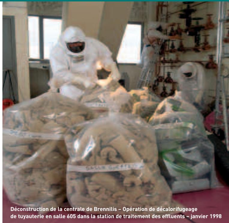
Déconstruction de la centrale de Brennilis – Opération de décalorifugeage de tuyauterie en salle 605 dans la station de traitement des effluents – janvier 1998
