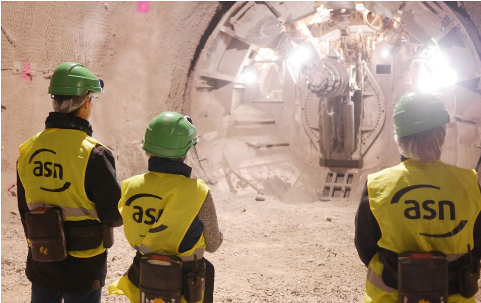
Visite de l'ASN lors de la phase de creusement du réseau de galeries du laboratoire souterrain de Bure.
