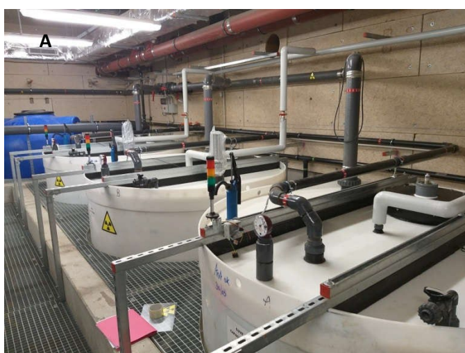
Fig. 11 – Cuves de décroissance de l'unité de médecine nucléaire (A) et de l'unité de curiethérapie (B)
