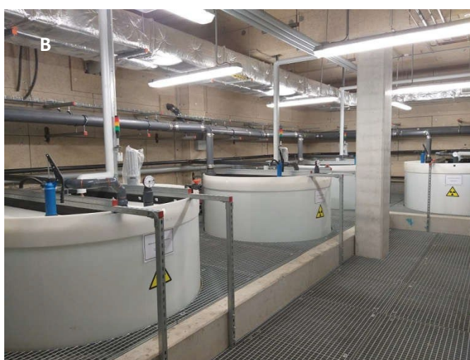
Fig. 11 – Cuves de décroissance de l'unité de médecine nucléaire (A) et de l'unité de curiethérapie (B)
