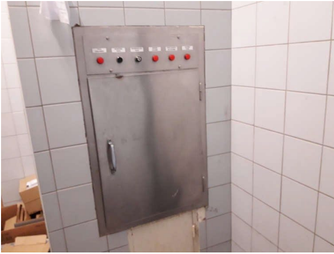
Fig. 7 – Trappe de collecte des déchets DAOM et pied de colonne avec détecteur de radioactivité
