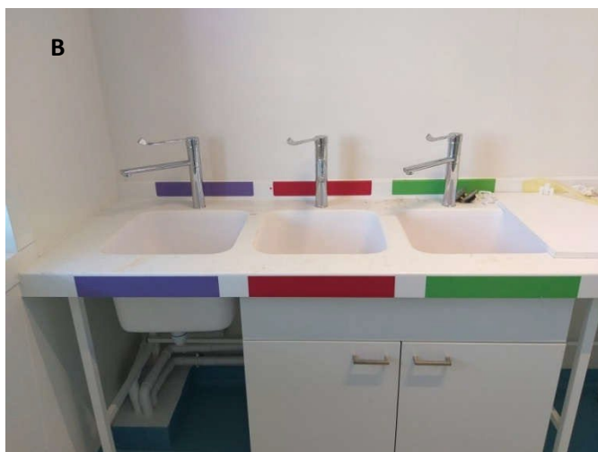
Fig. 10 – Evier actif normal en rouge (A) et évier vers les cuves de curiethérapie, en violet (B)
