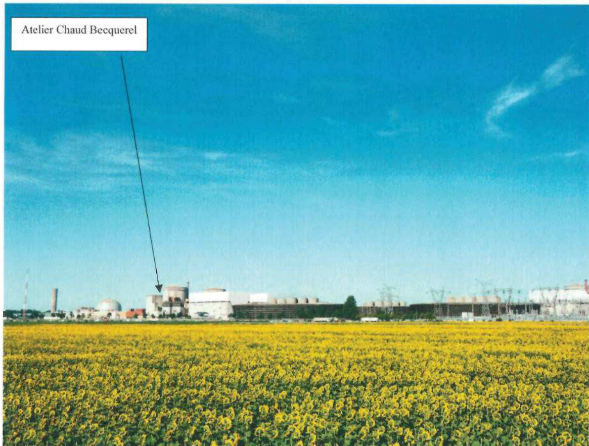
Prise de vue n°2 – projet dans l'environnement lointain (23/07/2020)
