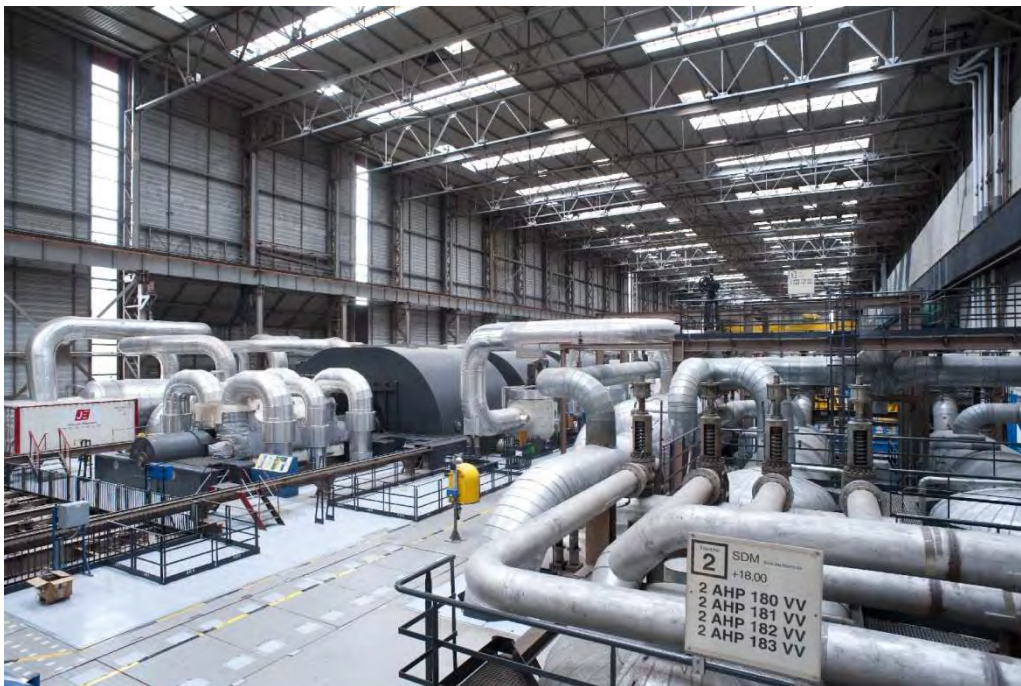
Figure 3 : Salle des machines, groupe turboalternateur
