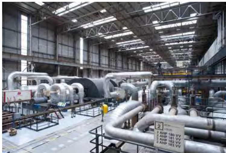
Figure 3 : Salle des machines, groupe turboalternateur
