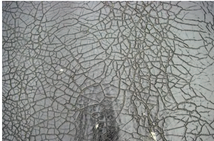
Figure 4 : Grand Terril des Charrées de chrome de Wattrelos - Géomembrane bitumineuse
