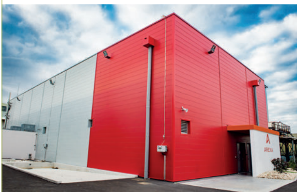
Le bâtiment commandement du site du Tricastin.
