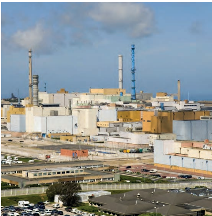
Usine de traitement des combustibles usés d'Areva, Établissement de La Hague, Manche.
