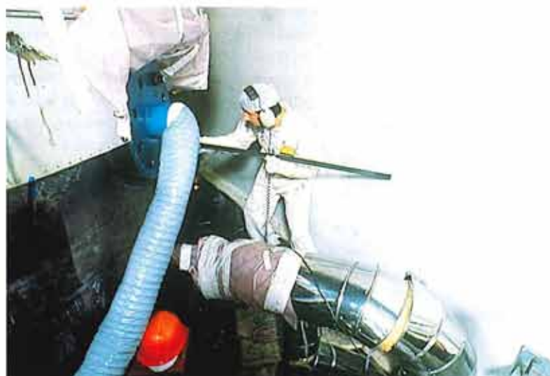
Contrôle d'un tube de générateur de vapeur
