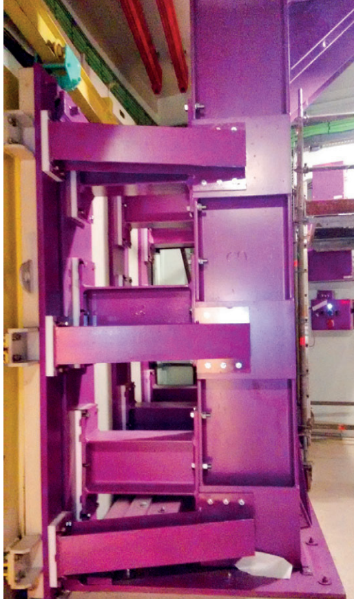
Éléments du « noyau dur » du RHF : renforcement d'une porte pour résister à une inondation extrême.
