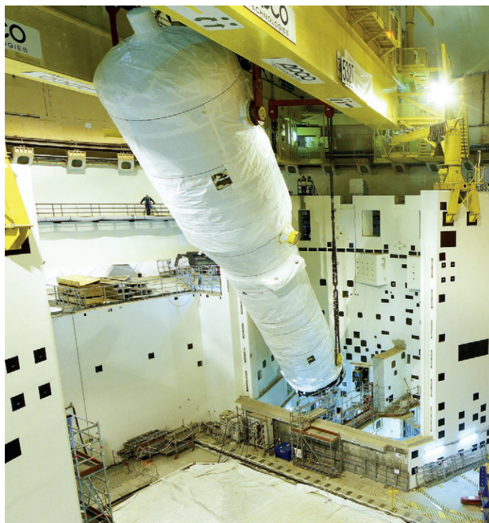
Levée des générateurs de vapeur.
