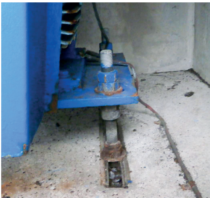
Ancrage au sol d'une pompe.
