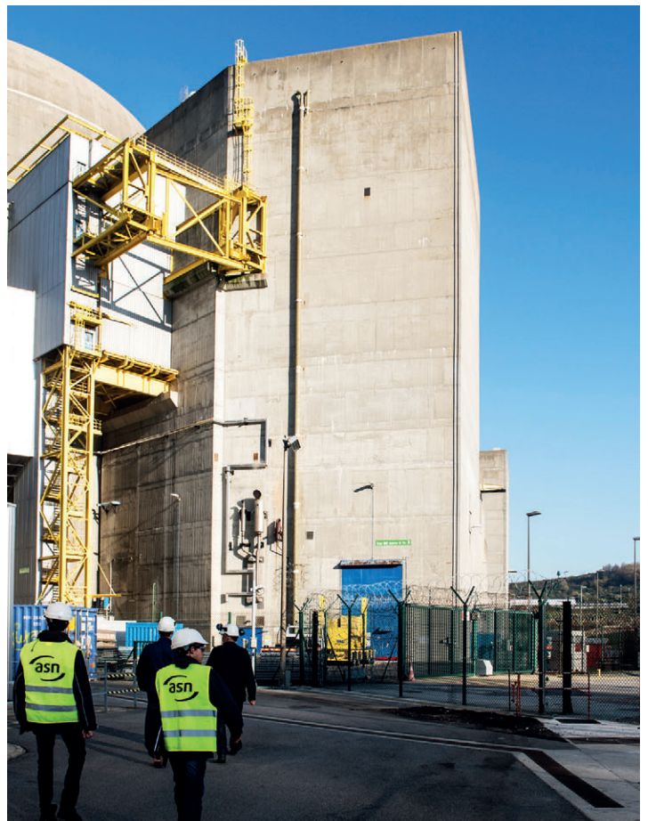
Inspection de l'ASN à la centrale de Paluel, novembre 2015.
