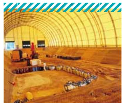
Mise en place de déchets TFA dans une alvéole de stockage, creusée à quelques mètres de profondeur dans une roche argileuse.
