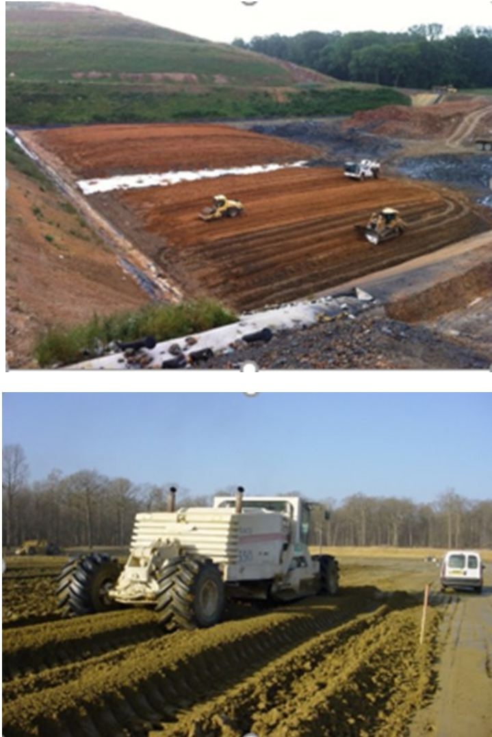
Figure 21 : Réalisation de barrières passives
