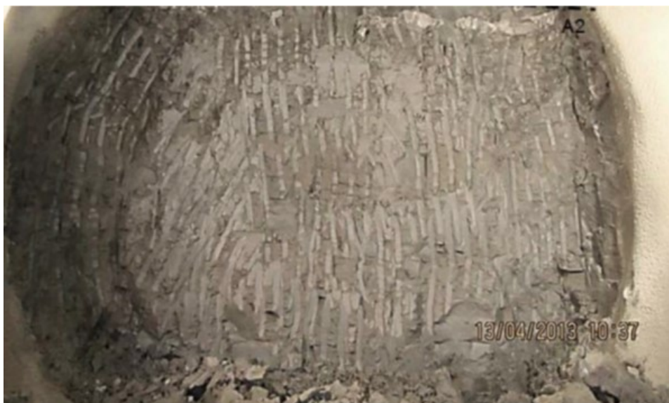
Figure 33 : Front de taille dans les argiles de Londres sans renforcement
