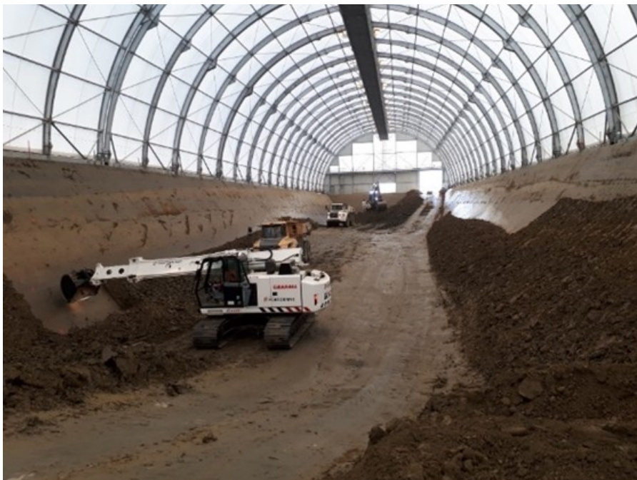
Figure 23 : Terrassement à l'abri d'un dôme de protection
