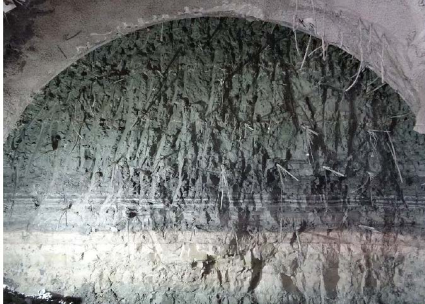
Figure 30 : Front de taille avec renforcement par boulons fibre de verre
