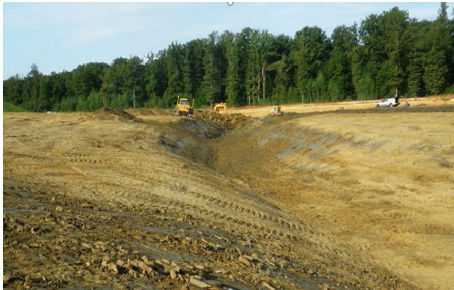
Figure 22 : Zones de déblai/remblai d'argile
