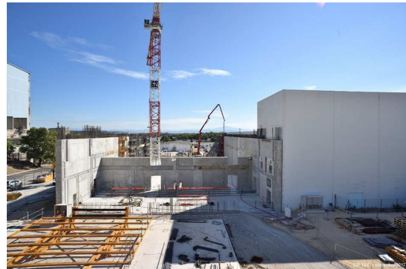
EIP : Construction des alvéoles 3 et 4 en cours
