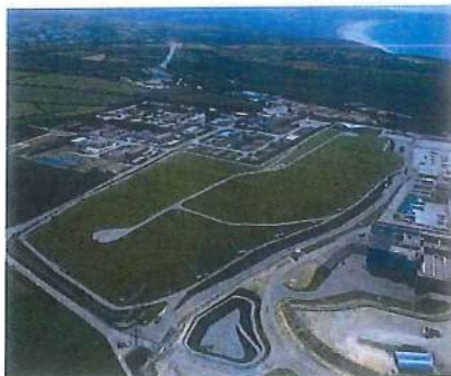
Centre de stockage de la Manche (CSM)-source ANDRA
